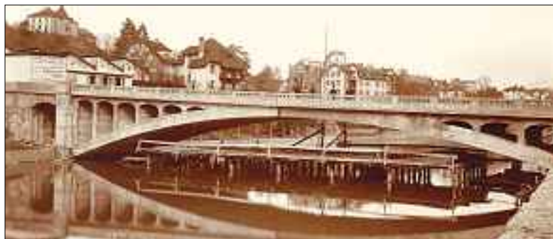
Die alte St.-Karli-Brücke kurz vor der Eröffnung. Bild: Stadtarchiv Luzern
